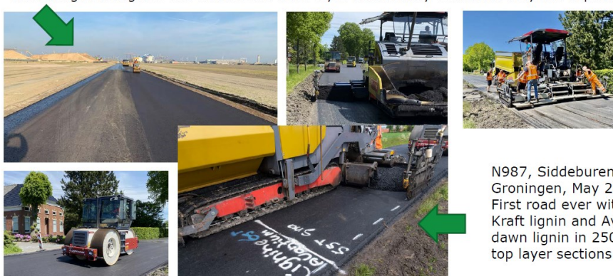
Fig. 4. Carreteras construidas empleando una mezcla lignina-betún 1:1 (Fuente: JUNGINGER, M.; Lignocost 2020).
